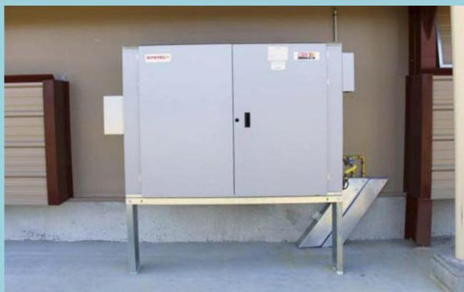
↑ Trois générateurs à combustion indirecte (CBX80, Systel) permettent de chauffer le poulailler.
